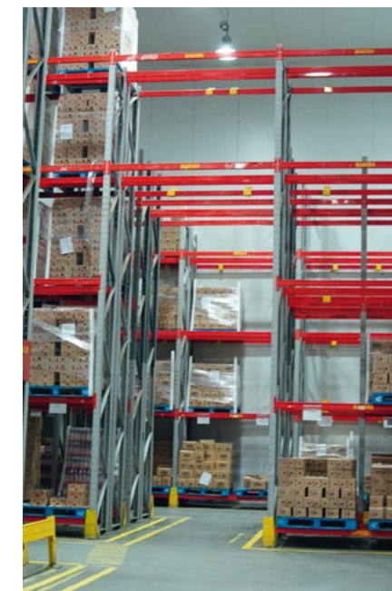
CD Danone Santiago (Bodega de Frío)
